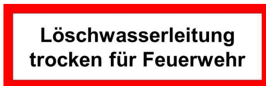
Abb. 12: Kennzeichnung der Löschwasserentnahme („trocken“)
